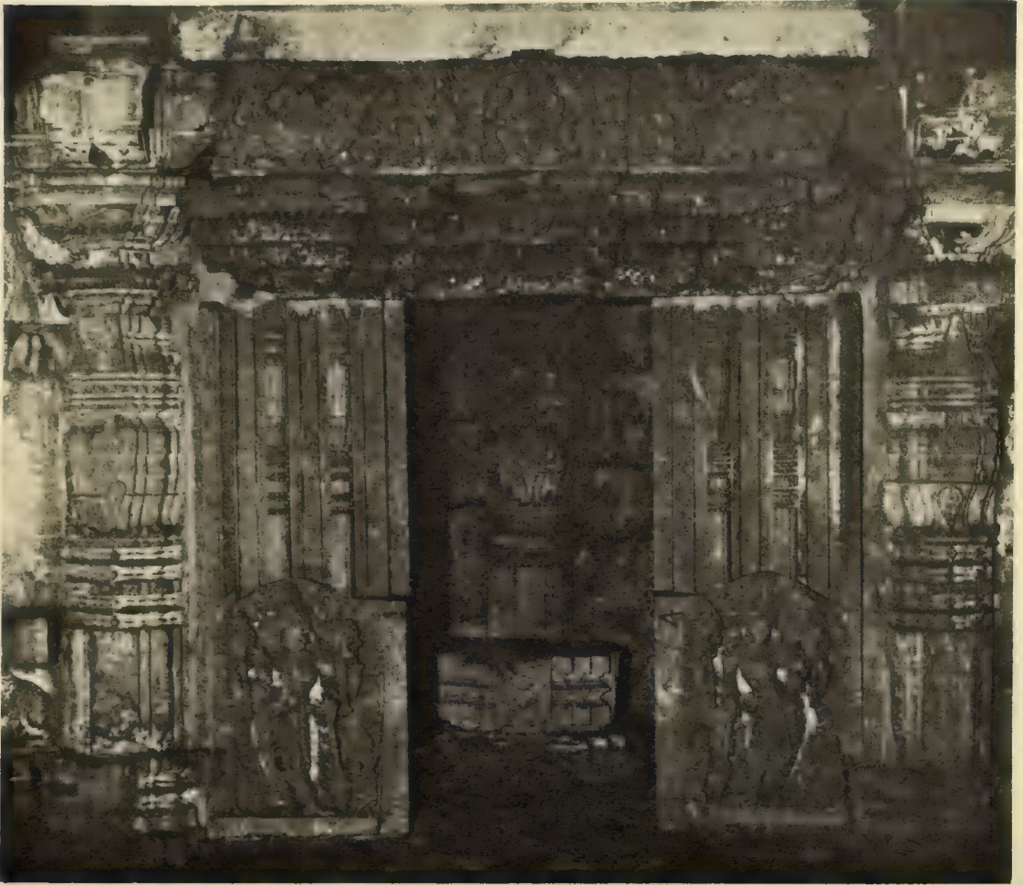
Fig. 16. The doorway with Vaiṣṇava dvārapālas in the Kēdārēśvara. 1969.
